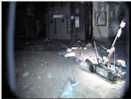
福島第一原子力発電所1号機原子炉建屋に入った遠隔操作ロボット(右)。奥には分電盤が見える=17日、東京電力提供
